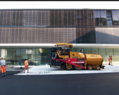
Strassenbau am Schulplatz
