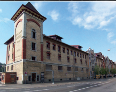
Standort Lagerhäuser St. Gallen
