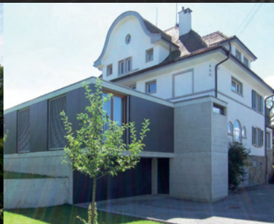
Anbau und Sanierung Jugendstilvilla
