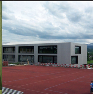
Erweiterung Schulhaus Abtwil
