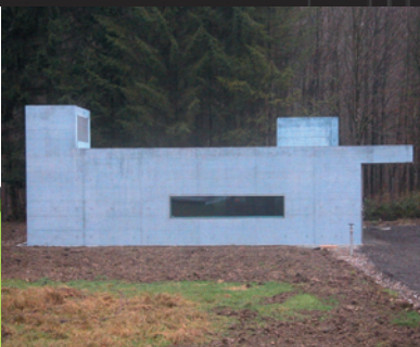
Pumpwerk, Blauer Beton
